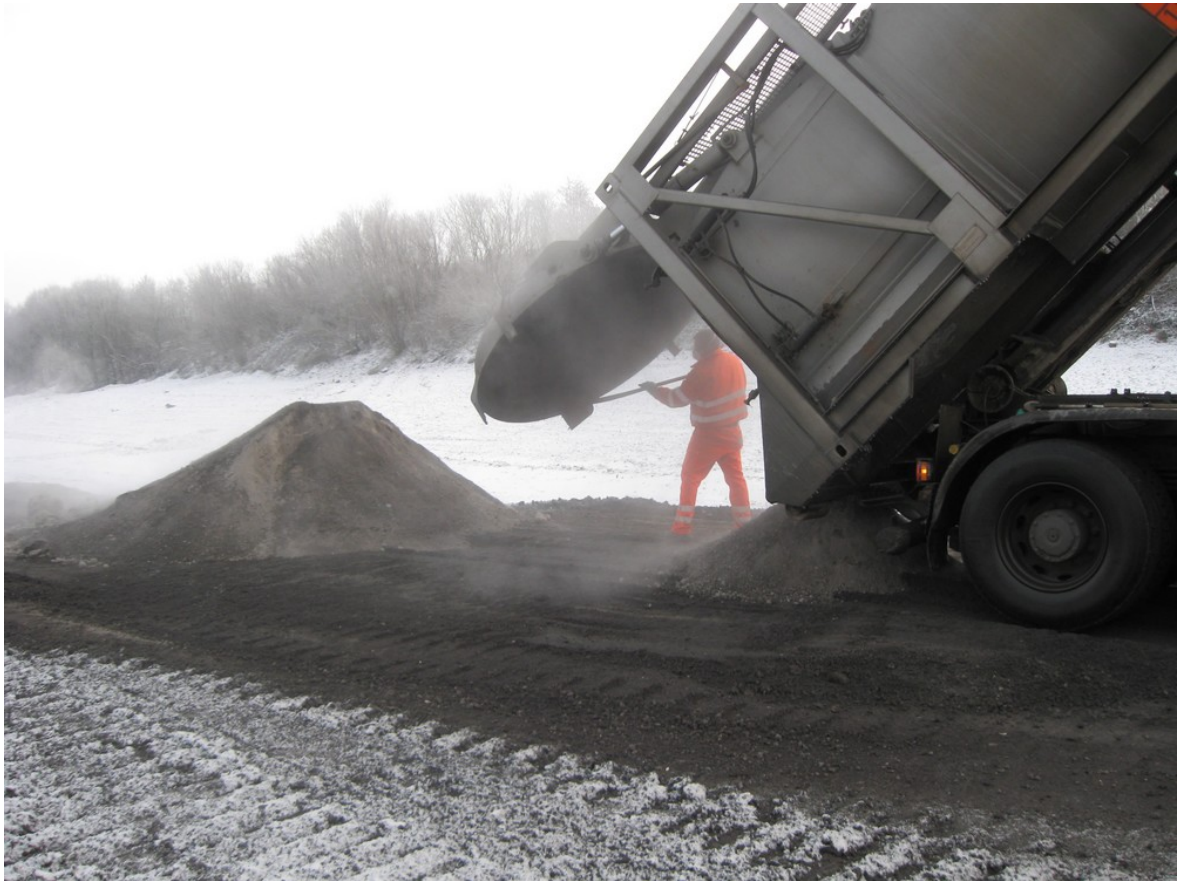
Abb. 6: Der Mitarbeiter (weitgehend ungeschützt!) versucht, Reste von Filterstaub an der Klappe zu entfernen.
