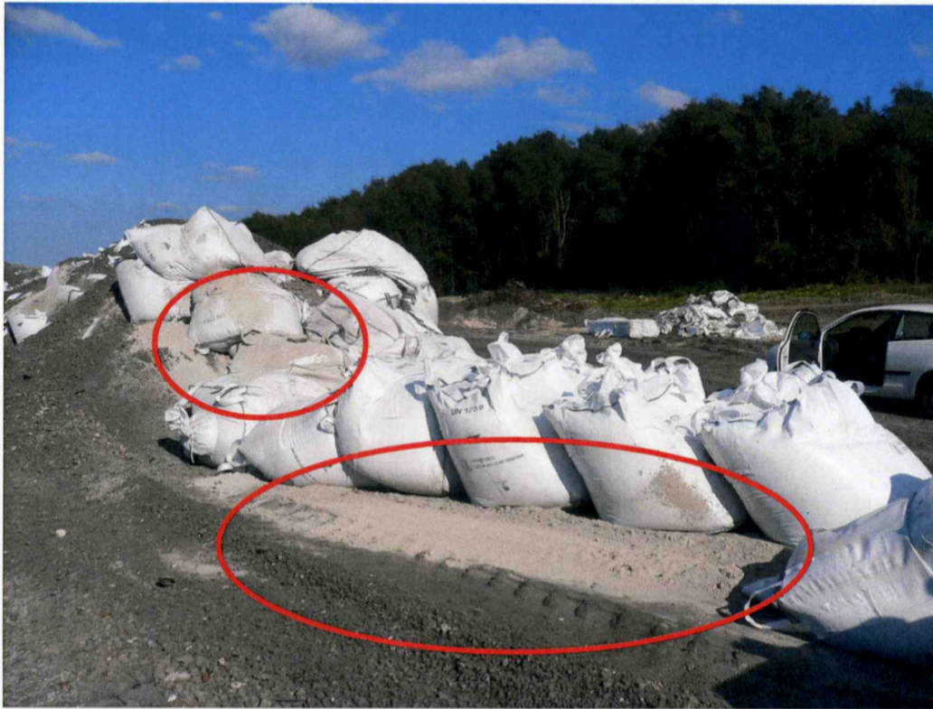
Abb. 8: Auf der Deponie Grauer Wall rieselt Filterstaub aus aufgerissenen Säcken heraus (siehe rote Kreise).
