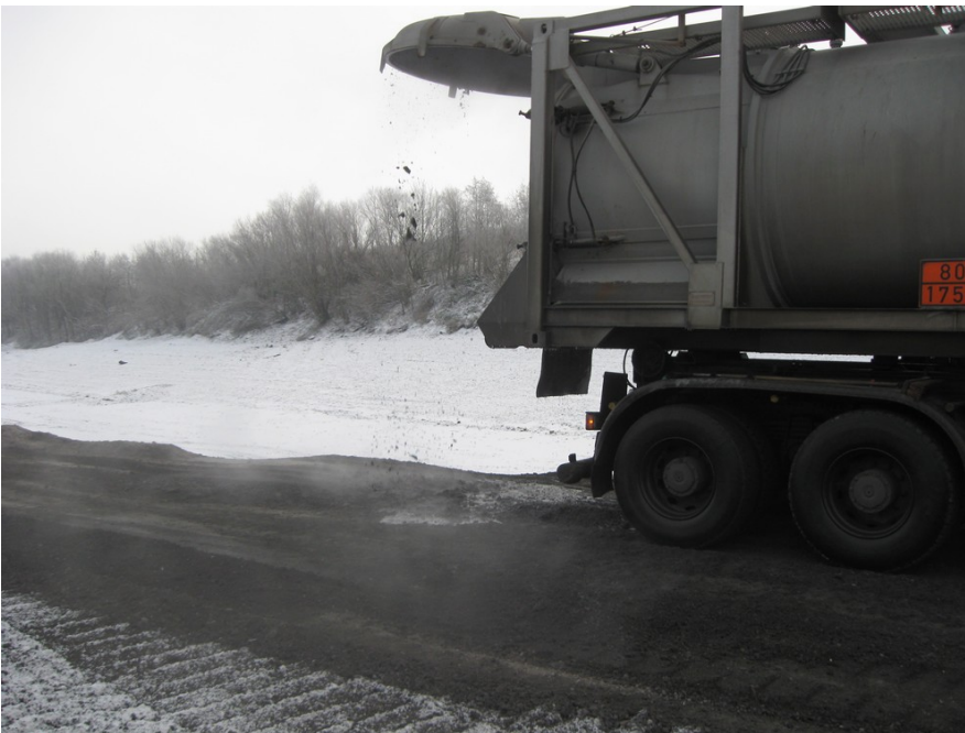
Abb. 3: Das Silofahrzeug mit Filterstaub kommt an und öffnet die Klappe, der erste Filterstaub rieselt herunter.
